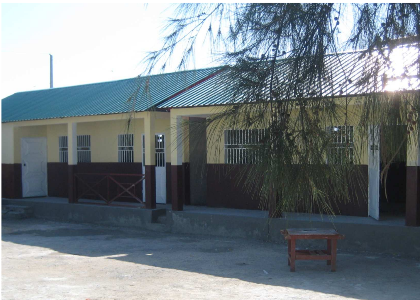
Le nouveau bâtiment du Primaire
